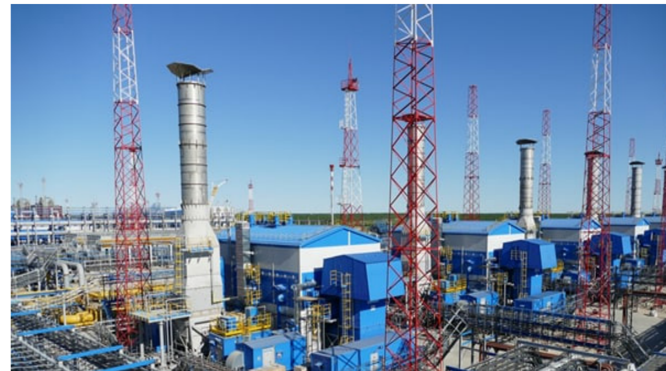
Проект «Сила Сибири» Дожимная компрессорная станция Ямбургского НГКМ
